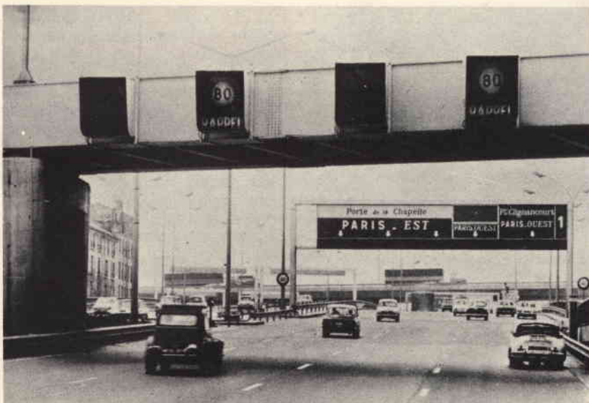
Fig. 11 - Esempio di segnaletica autostradale di rallentamento, realizzata mediante l'impianto radar su di un'autostrada francese.
